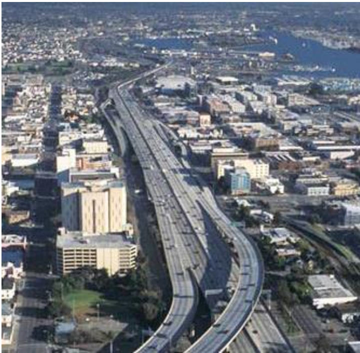
Vista aérea del Proyecto de Acceso Oakland Alameda.
