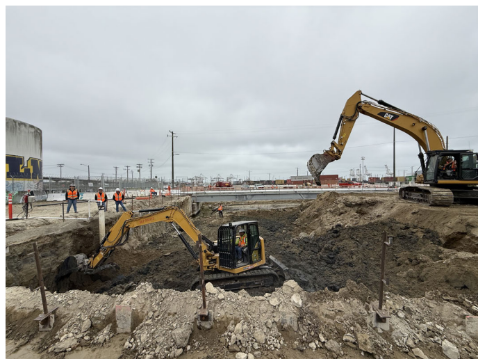
Las cuadrillas de Ghilotti están excavando la nueva alineación de la Calle 7.
