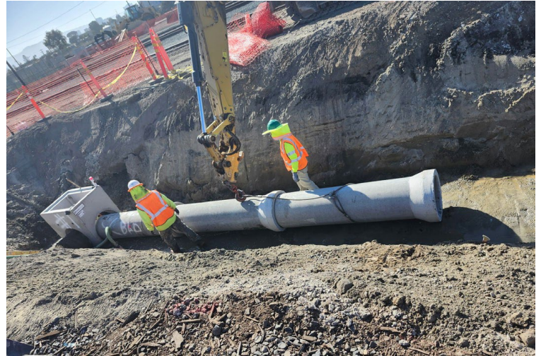
Drenaje pluvial en instalación junto con la nueva alineación de la Calle 7.
