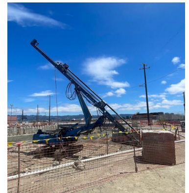
Perforadora de anclajes, perforando agujeros para la instalación del muro de anclajes.
