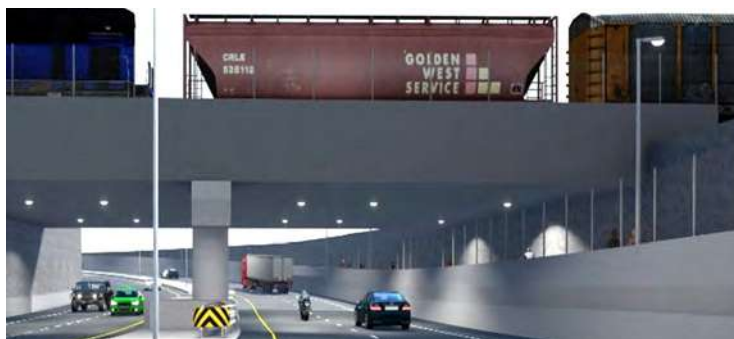
Paso a desnivel de la 7th Street con poco espacio libre y anchura de carril
