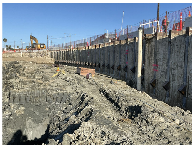
Se están instalando muros de anclaje junto a la excavación.
