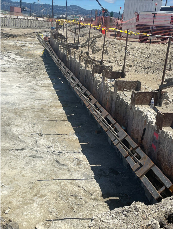
Primera fila de instalación de anclajes.
