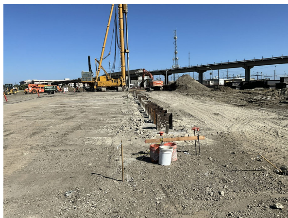
Instalación del muro con Mezcla Profunda de Suelos (DSM) en el lado este del proyecto.
