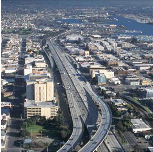
Nhìn từ trên không của Dự án Tiếp cận Oakland Alameda.
