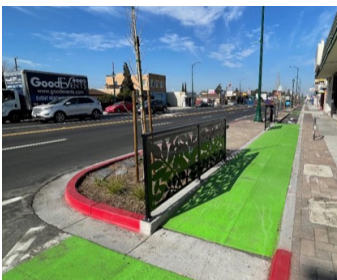
受保护自行车道: Ashland 自行车道 (配有绿色雨水基础设施缓冲带)
