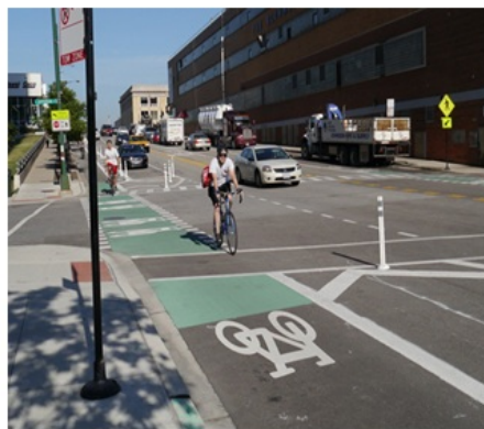
(B: Intersección protegida, imagen a modo ilustrativo)
