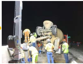
Median Barrier Construction - Concrete Pour
