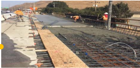
Calaveras Road Bridge Widening Deck Pour
